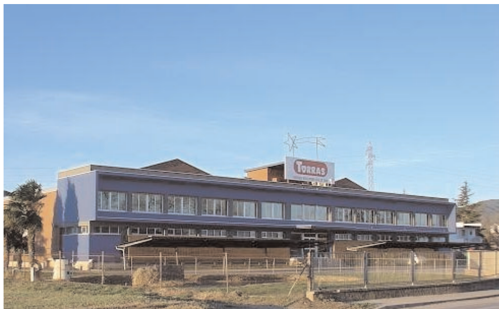
Vista de la fàbrica de Chocolates Torras
