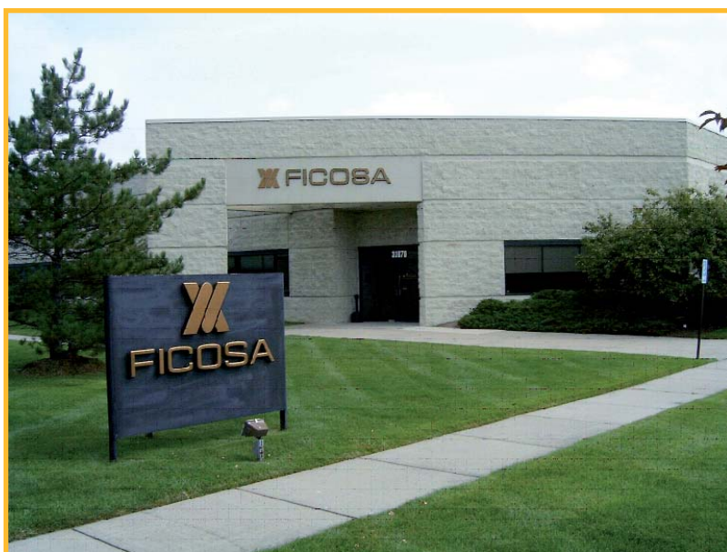
Figura 21. Foto Centre Tècnic a Detroit
