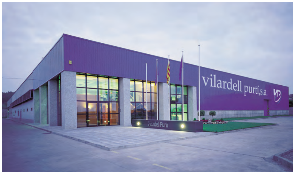
Instal·lacions de Vilardell Purti, al polígon Santa Anna de Santpedor (Bages)
