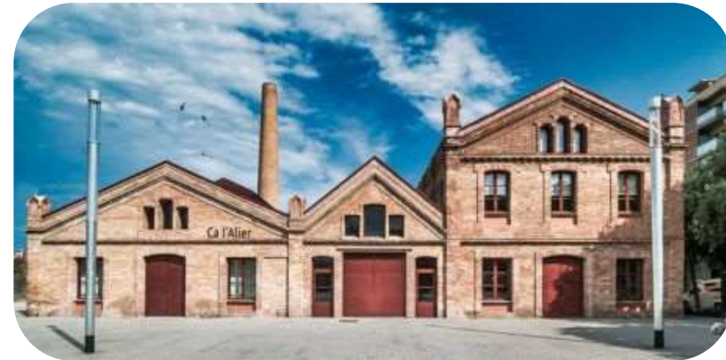
Les instal·lacions de Cisco a Barcelona, més de 3.000 m 2 a l'antiga fàbrica de Ca l'Alíer, a la zona del 22@.
